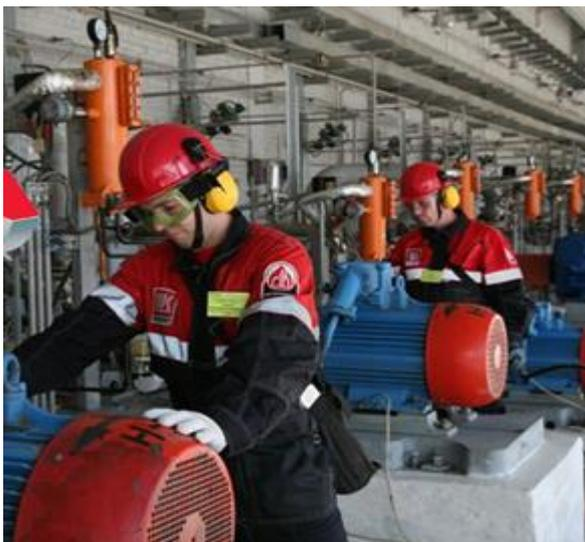
Сферой профессиональной деятельности машиниста технологических насосов являются знания принципа работы и правил эксплуатации поршневых и центробежных насосов, основных типов компрессоров, свойств перекачиваемых продуктов и их параметров, основ слесарного дела.
